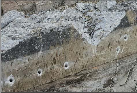
Die mit der Umgestaltung betraute Firma Schwyzer Bau GmbH stiess beim Abbruch der alten Beton-Umrandungen auf unerwartete Probleme, zeigte sich der im Erdreich liegende Teil der langen Mauer doch als äusserst hartnäckig. Der Abbruch musste durch Kaltsprengung unterstützt werden. Im Bild ein kleiner Teil der Bohrlöcher.
